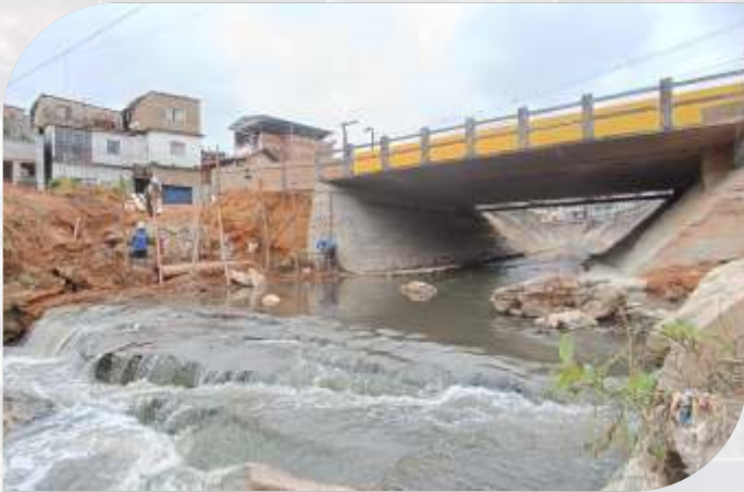
Ponte da Rua Bahia
